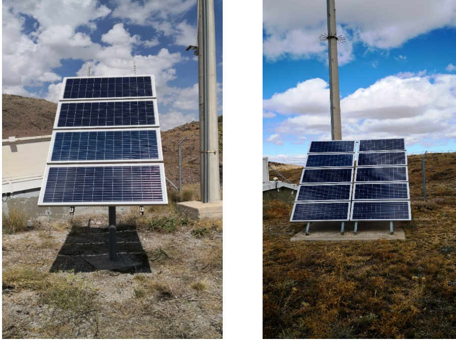
Şekil 1. AFTAC projesi kapsamında değiştirilen güneş panelleri örnek görselleri
